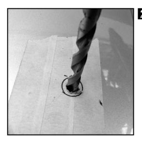
2 Reling nochmals auflegen und Bohrungen kontrollieren, ggf. nacharbeiten. Korrekte Bohrungen auf Ø7mm aufbohren und Kreppband entfernen.
